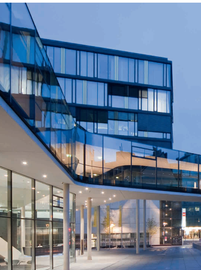
Eingang AachenMünchener Platz
