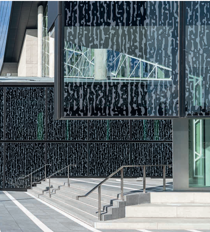
Weißer Punktrasterbedruckung auf der Außenscheibe
