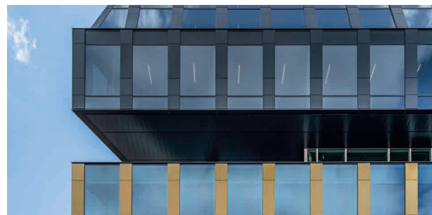
Detailansicht der Fassade
