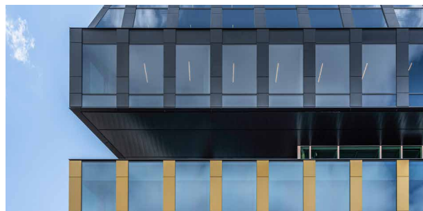
Detailansicht der Fassade
