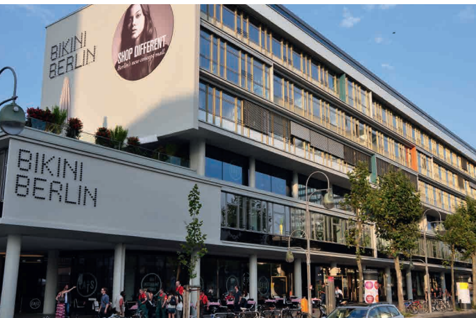
Süd-Westansicht der Denkmalgeschützten Fensterfassaden
