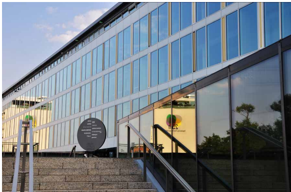
Aufgang West zum Bikini-Garden mit Blick auf die Nordfassade
