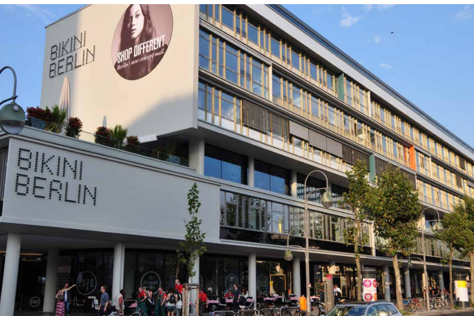
Süd-Westansicht der Denkmalgeschützten Fensterfassaden
