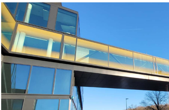
Verbindungsbrücke mit Twin-View-Siebdruck
