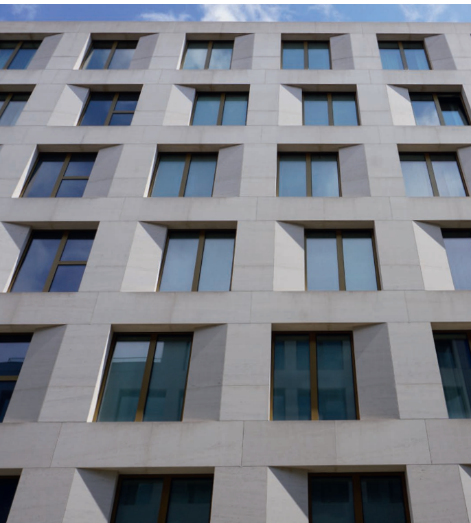
Detailansicht der Fassade
