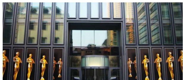
Pfosten-Riegelfassade Osteingang
