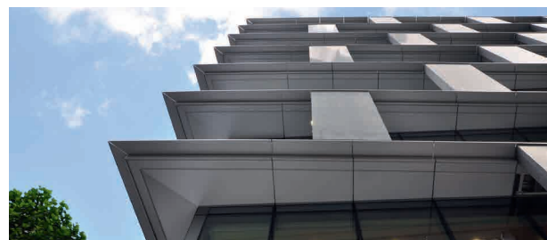
Ausragender Sonnenschutz und Fertigbetonbauteile am Neubau
