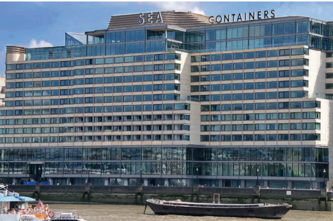
Kernsanierter Altbau mit aufgesetzter Roof Top Bar - Nordansicht mit Themseufer
