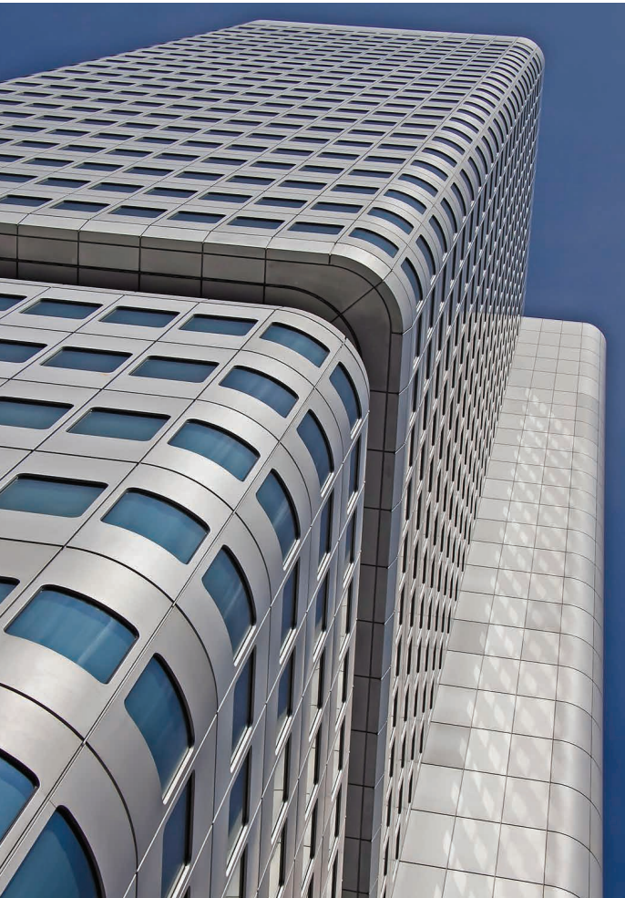
Fassadenansicht mit Treppenhaus im Vordergrund
