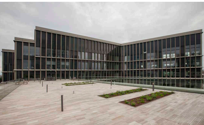
Ostansicht, Dachterrasse 6. OG
