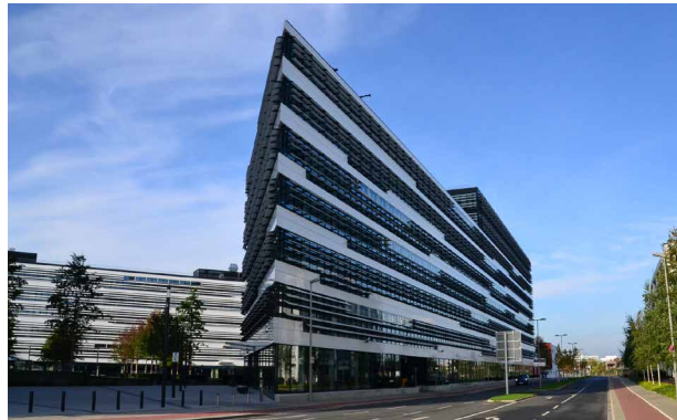
Links Bauteil B und rechts Bauteil C
